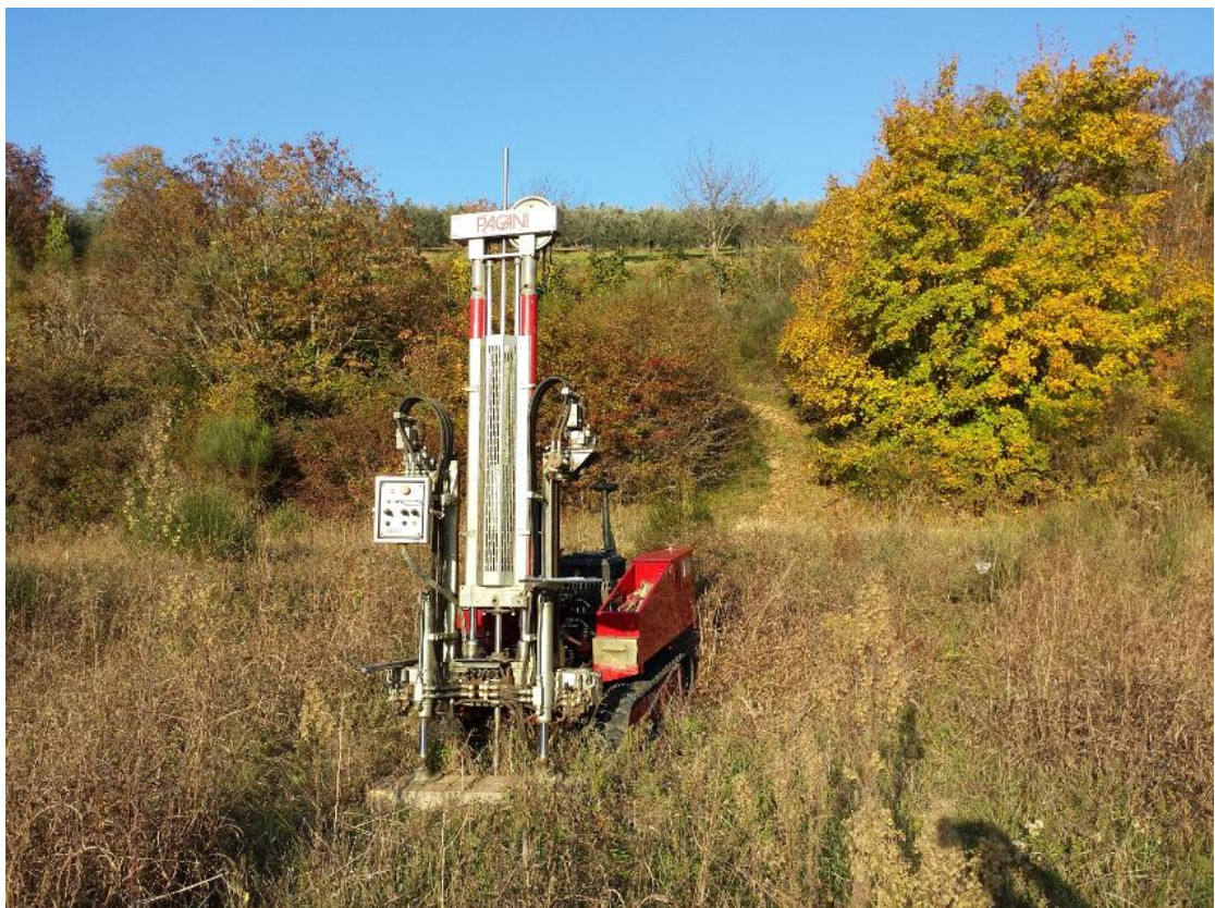
Foto n° 6 – Ubicazione penetrometria n° 3
