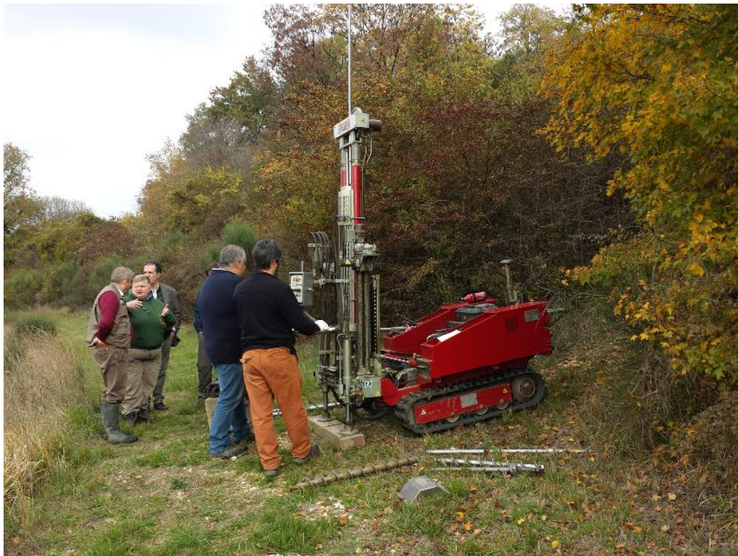
Foto n° 4 – Ubicazione penetrometria n° 1
