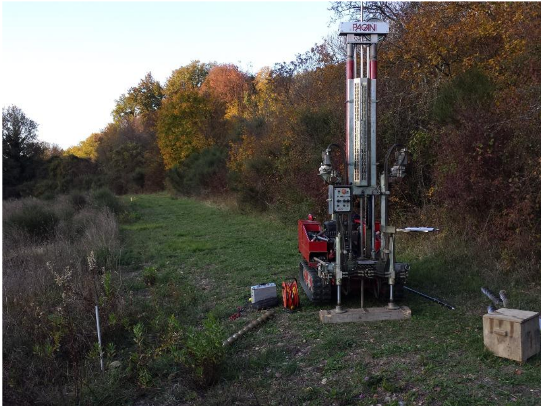
Foto n° 7 – Ubicazione penetrometria n° 4
